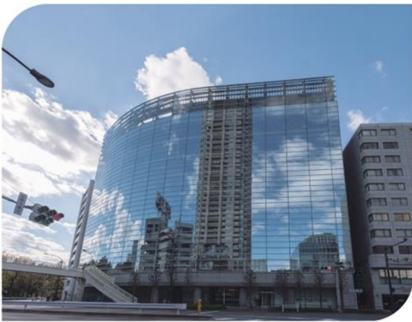
ヒューリック青山外苑東通ビル
